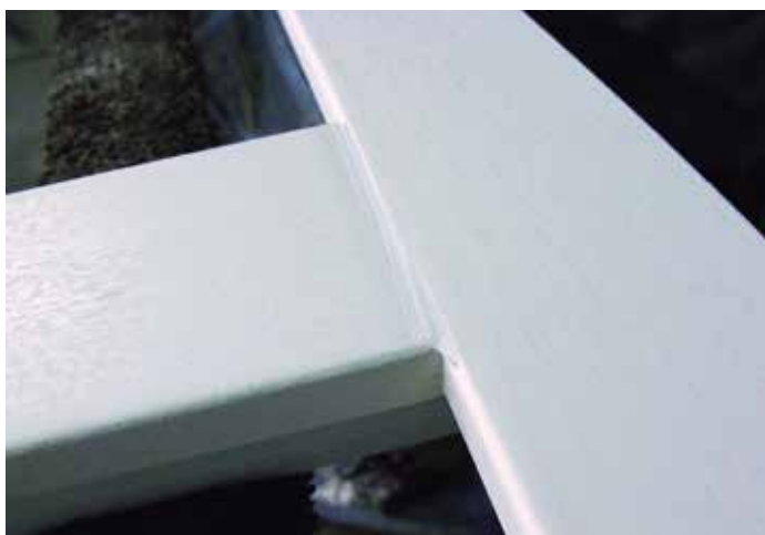
Wypełnienie spoin V przed nałożeniem końcowej powłoki: Induline AF-920
