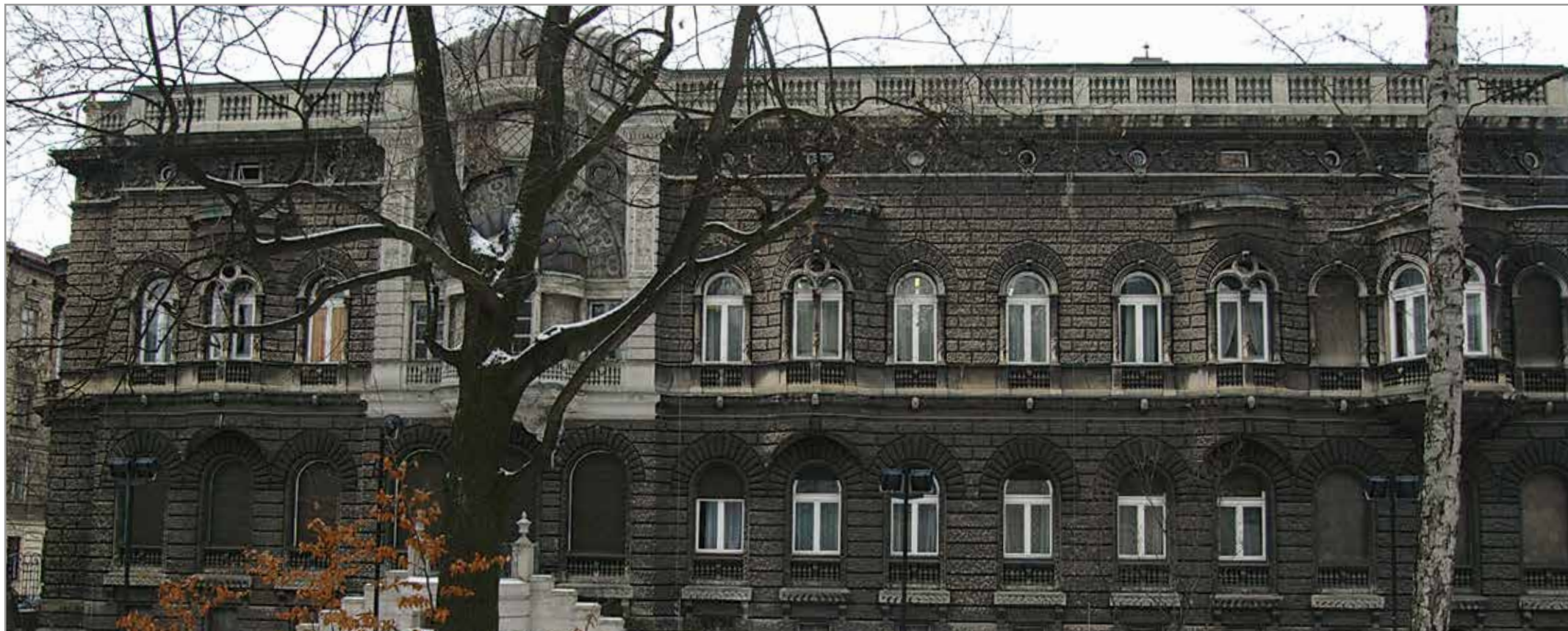
Akademia Muzyczna w Łodzi przed renowacją - widok od strony ogrodu
