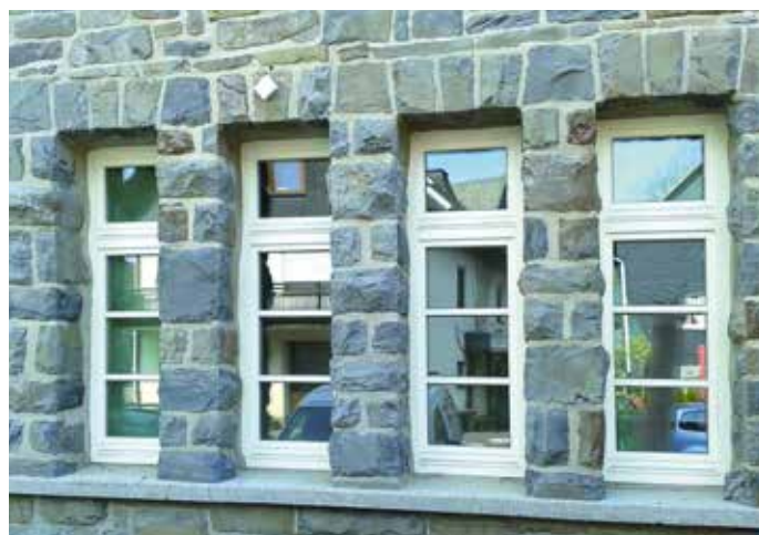
Nowe okna zachowują wygląd historycznej elewacji
