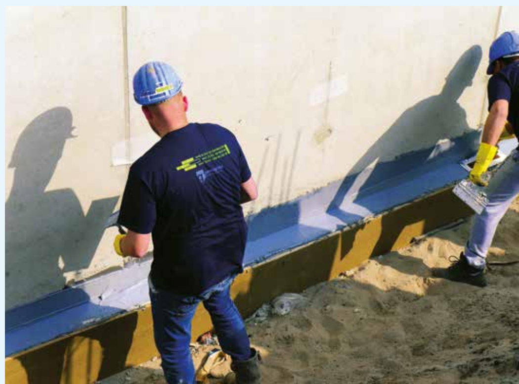
Wykonywanie fasety uszczelniającej
