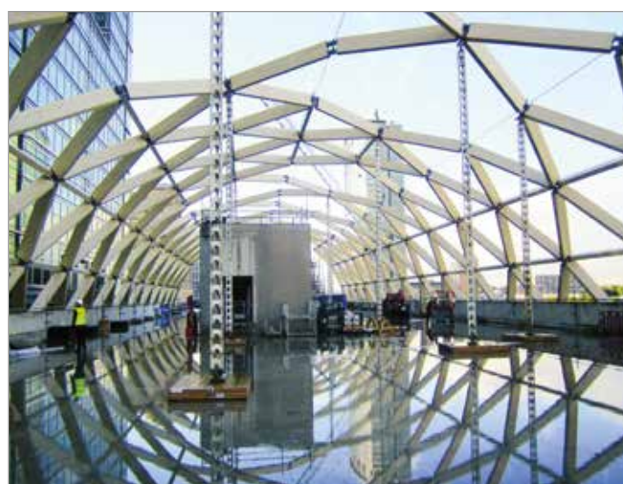
Kratownicowa konstrukcja dachu z 3050 połączeniami
